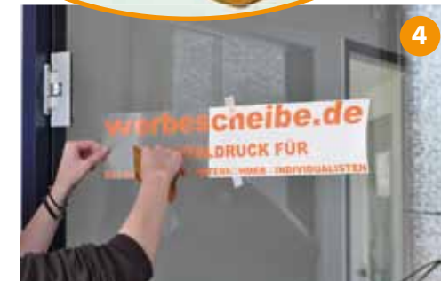
Mit einem Rakel vorsichtig das Applikations-tape inkl. Plotts andrücken
