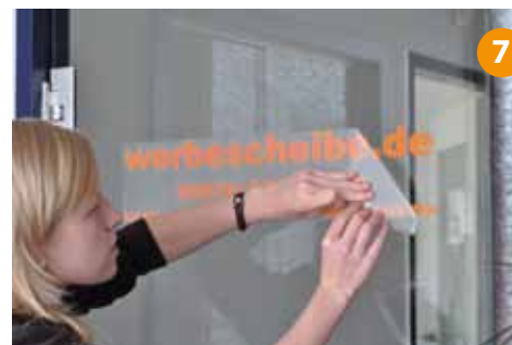
Applikationstape an einer Ecke anlösen und im flachen Winkel abziehen
